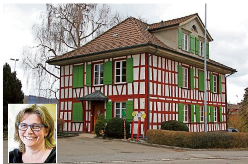
Eine nähere Betrachtung der einzelnen Gebäude der Schule Niederwil hat laut Gutachten gezeigt, dass für das Riegelhaus aus dem Jahr 1841 eine Totalsanierung anstehen würde. Der Bauzustand sei absolut mangelhaft. Ob es nach einer Schulraumerweiterung bestehen bleibt, ist laut Schulratspräsidentin Maria Rohner (kl. Bild) noch unklar. mia
